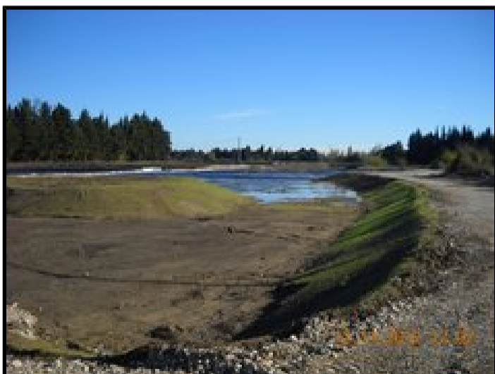
Travaux de la zone de rejet végétalisée – novembre 2012
