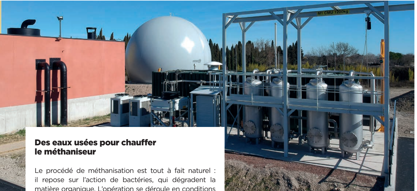
Le stockage du biogaz, ultime étape de la filière de méthanisation © Eau de Nîmes Métropole
