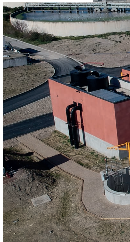
La nouvelle usine de méthanisation voisine la station d'épuration de l'Agglo (arrière plan) © Eau de Nîmes Métropole
