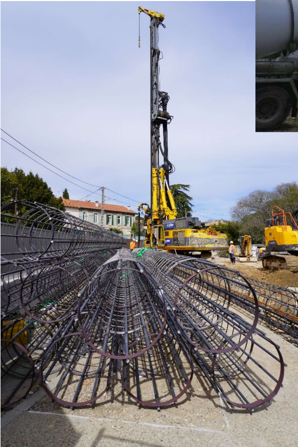
Photo du 18/03/2024 Stock de cage d'armatures pour pieux
