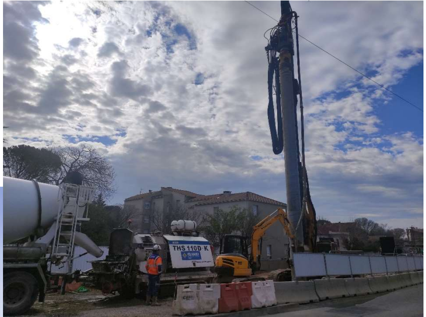
Photo du 18/03/2024 Atelier de forage et bétonnage de pieux
