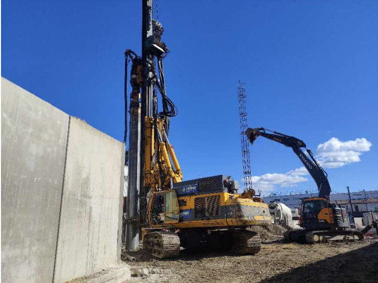
Photo du 05/03/2024 Atelier pieux : derniers pieux
