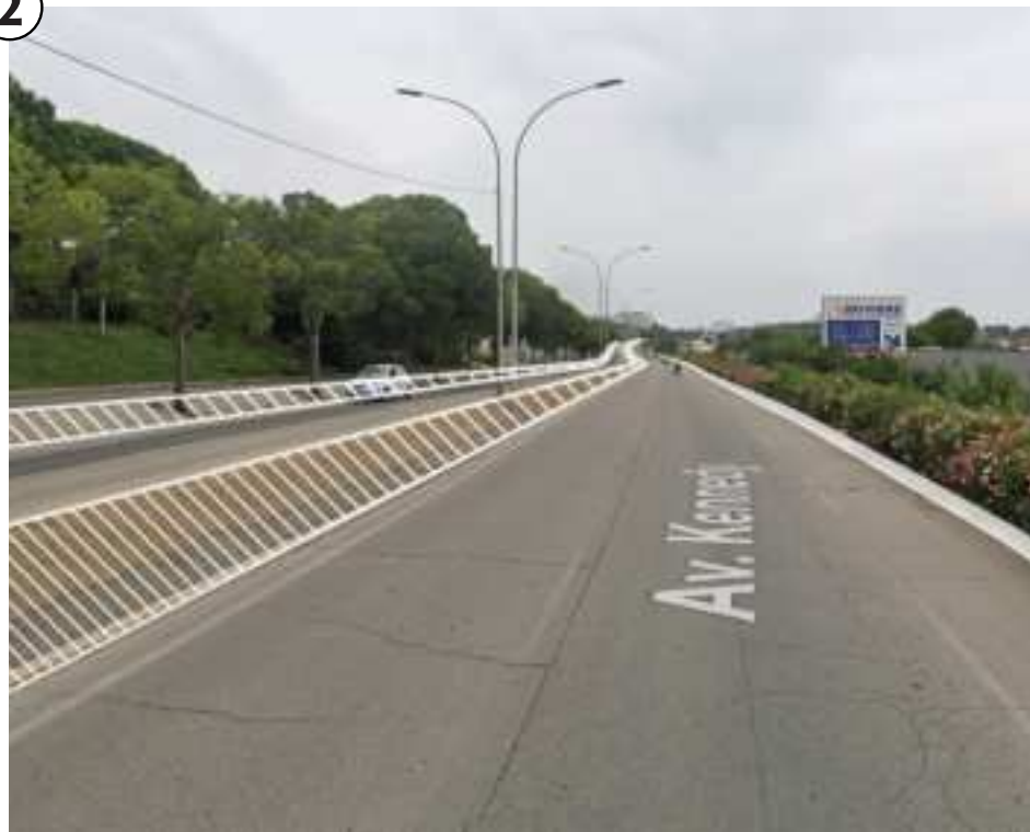
L'avenue Kennedy : un axe d'entrée dans Nîmes très passant, sans traversées entre Pavlov et Laënnec, et avec plusieurs dénivelés successifs
