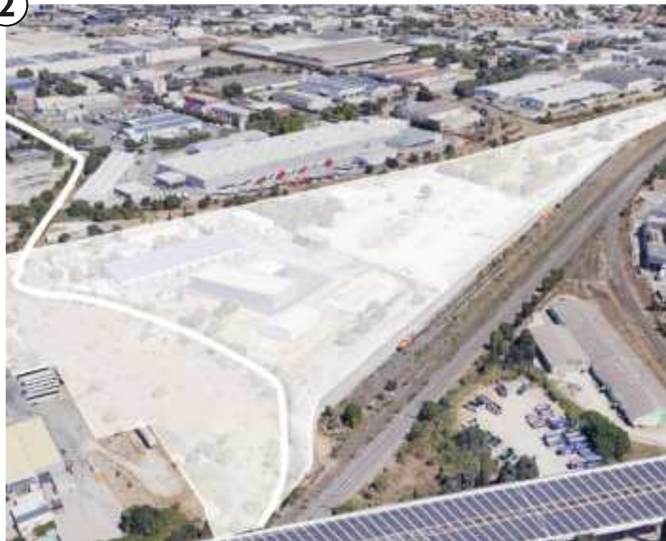
Le «triangle ferroviaire» entre la ZI Saint-Césaire et la voie ferrée : un espace stratégique en termes de continuité écologique et hydraulique.
