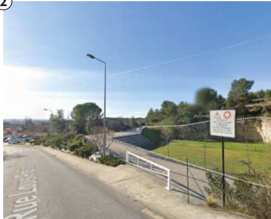
Des bassins de rétention (Romarin ci-dessus) en hauteur pour prévenir les inondations.
