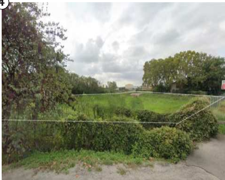
Le bassin de rétention paysager près de la gare de Saint-Césaire : un élément à réintégrer dans la continuité paysagère.
