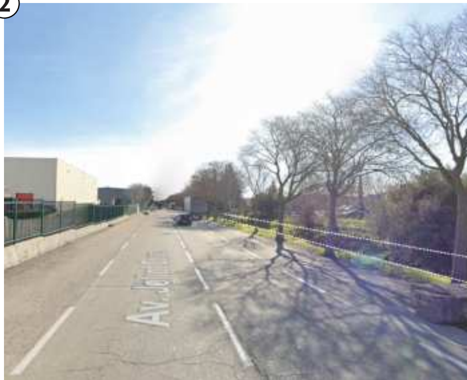
La Poudre canalisée le long de l'avenue Joliot Curie.
