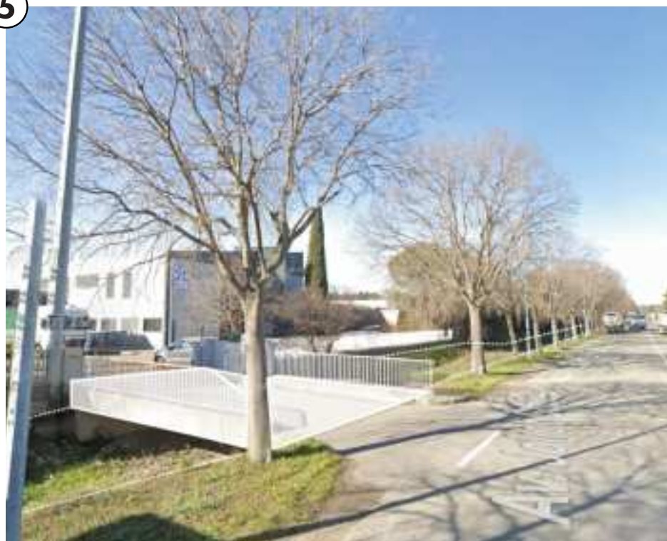
Des passerelles enjambant la Poudre permettent de desservir les entreprises adressées sur l'avenue Joliot Curie.
