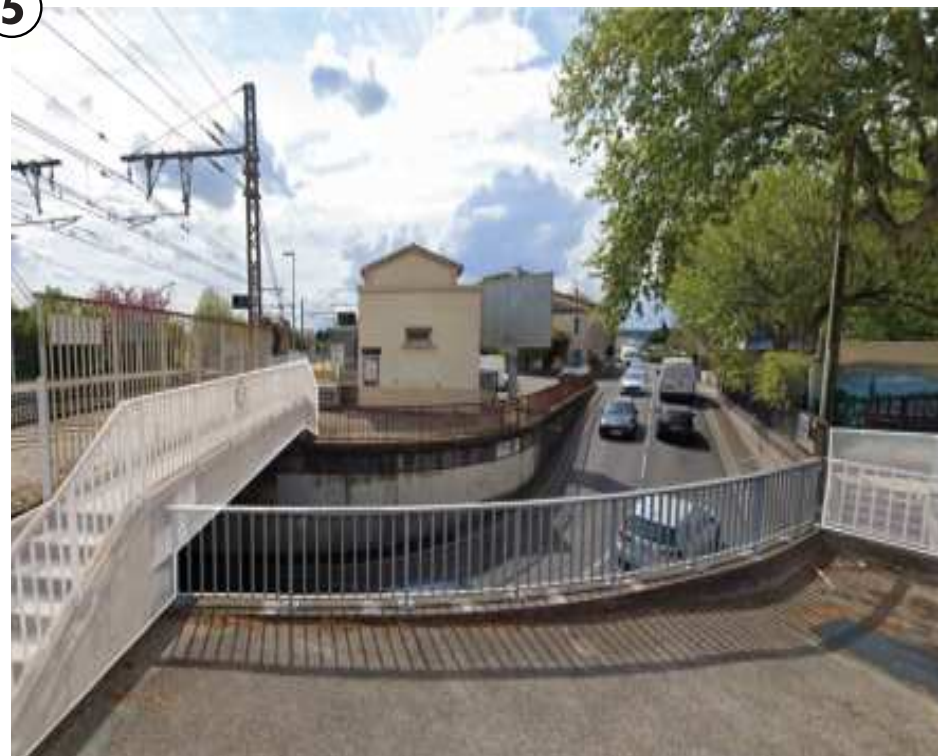
La gare est difficilement accessible depuis le centre de St-Césaire en raison de ses infrastructures obsolètes et inadaptées aux normes de sécurité et de mobilité actuelles.
