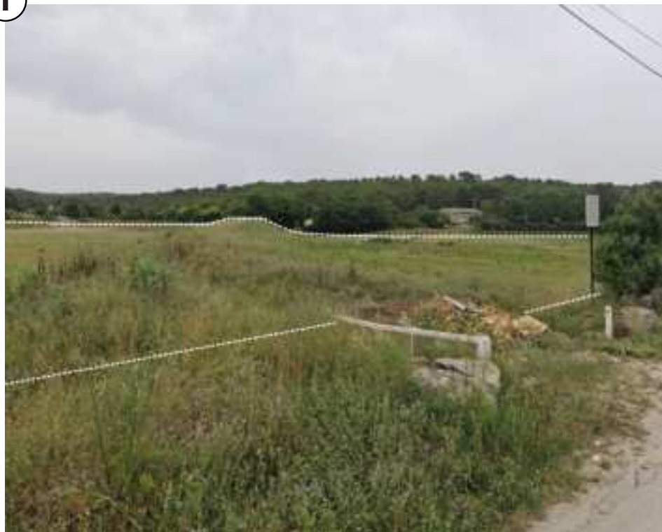
Les bassins de rétention de Canterpdrinx pour réguler les inondations en amont de la Z.I. St-Césaire.
