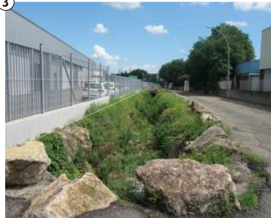
La partie à découvert, mais corsetée, du réseau pluvial sur foncier privé : l'expansion des crues nécessiterait plus d'espace en amont de la traversée des voies ferrées.
