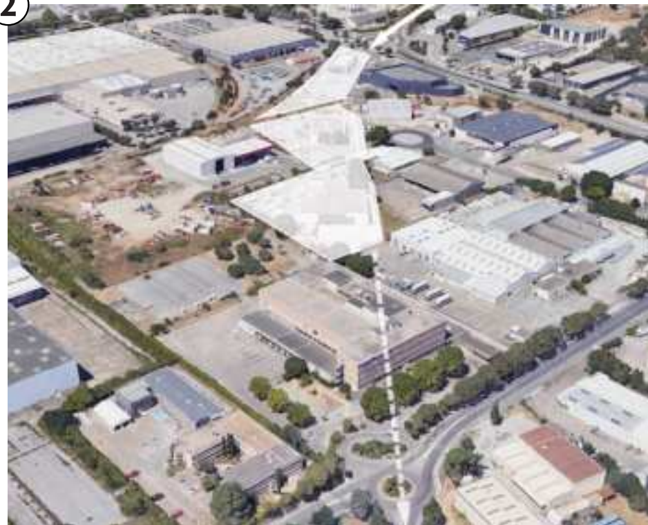
L'ancien tracé de la route de Sommières à Nîmes, effacé avec la création de la ZI, mais encore perceptible dans le parcellaire
