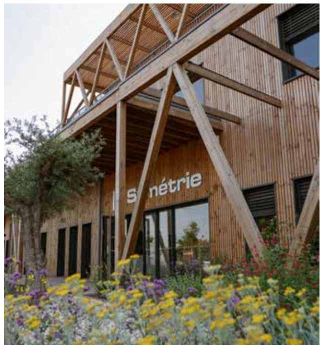
Siège de l'entreprise Symétrie à l'Actiparc de Bouillargues
