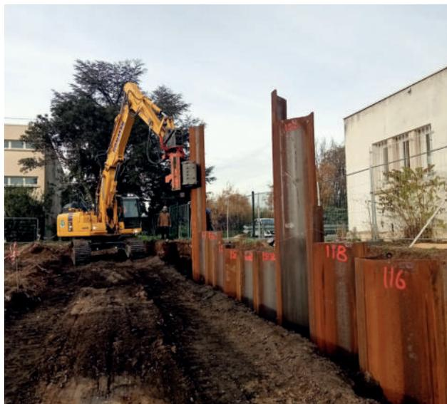
Installation de soutènements métalliques pour consolider le terrain
