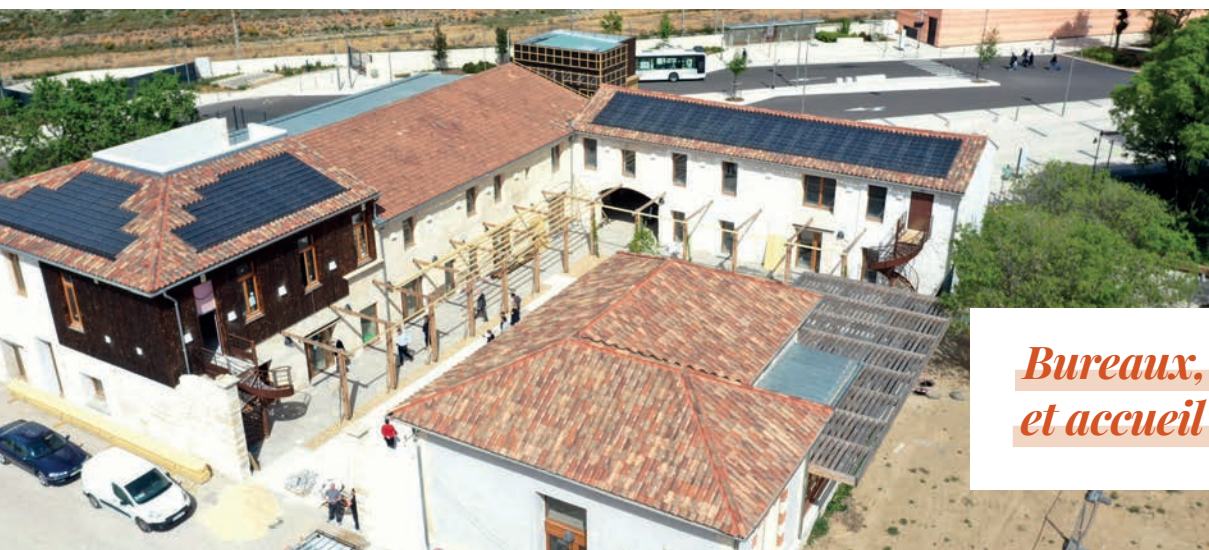
Vue aérienne du Mas Larrier en cours de rénovation
