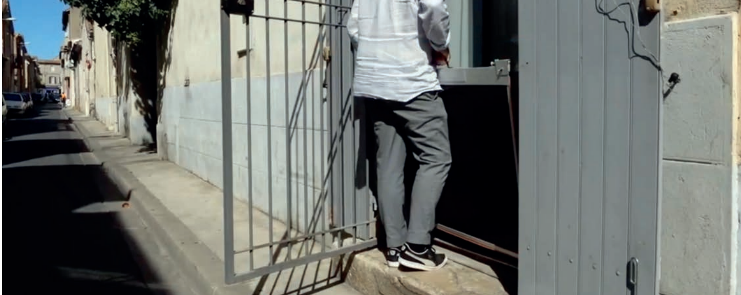
Installation d'un batardeau pour protéger une maison de ville de la montée des eaux. © Ville de Nîmes.
