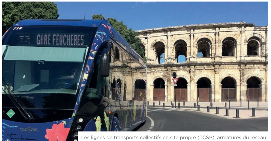
Les lignes de transports collectifs en site propre (TCSP), armoires du réseau.
