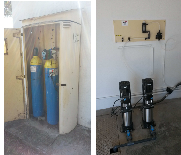
Photo 4 - système de chloration (bouteilles et hydroinjecteurs)
