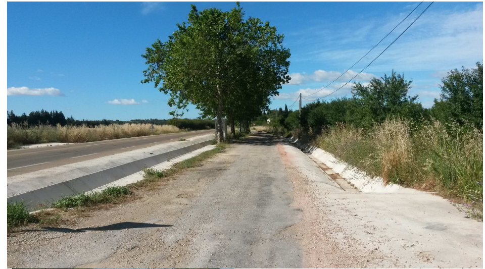
Photo 9 – Fossés de la RD135a bétonnés à proximité du PPI du Puits des Canaux
