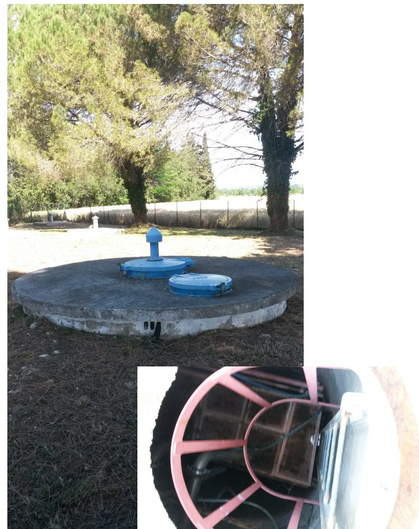
Photo 2 – Puits exploité (et vue de l'intérieur)
