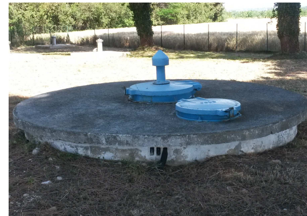
Photo 5 - Puits exploité (et vue de l'intérieur)
