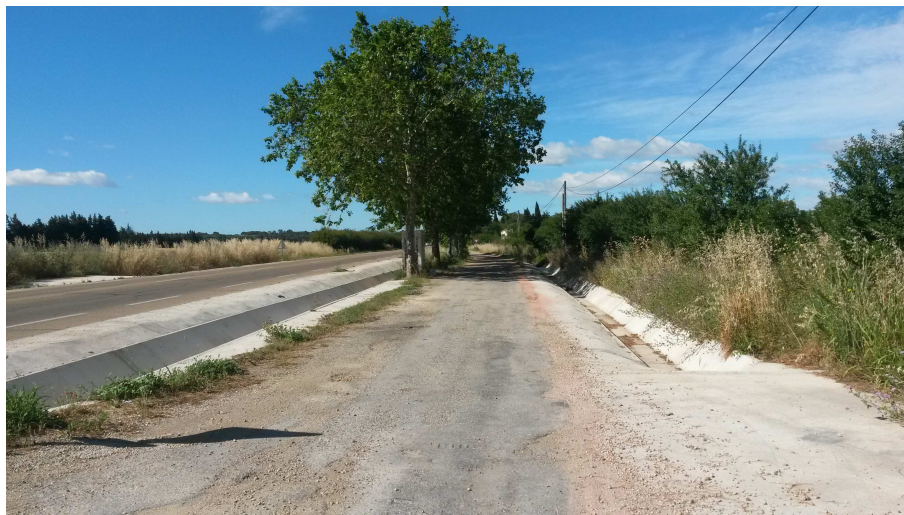
Photo 6 - Fossés de la RD135a bétonnés à proximité du PPI du Puits des Canaux
