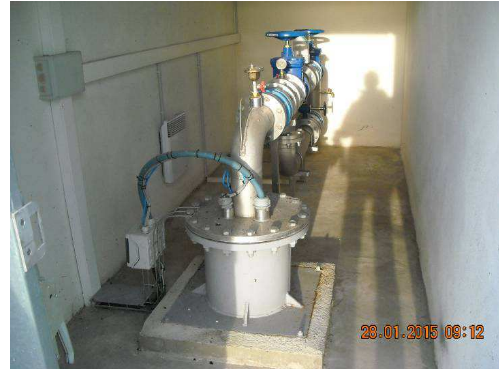
Photo 2 - Têtes des forages Fe1 (en haut) et Fe2 (en bas)
