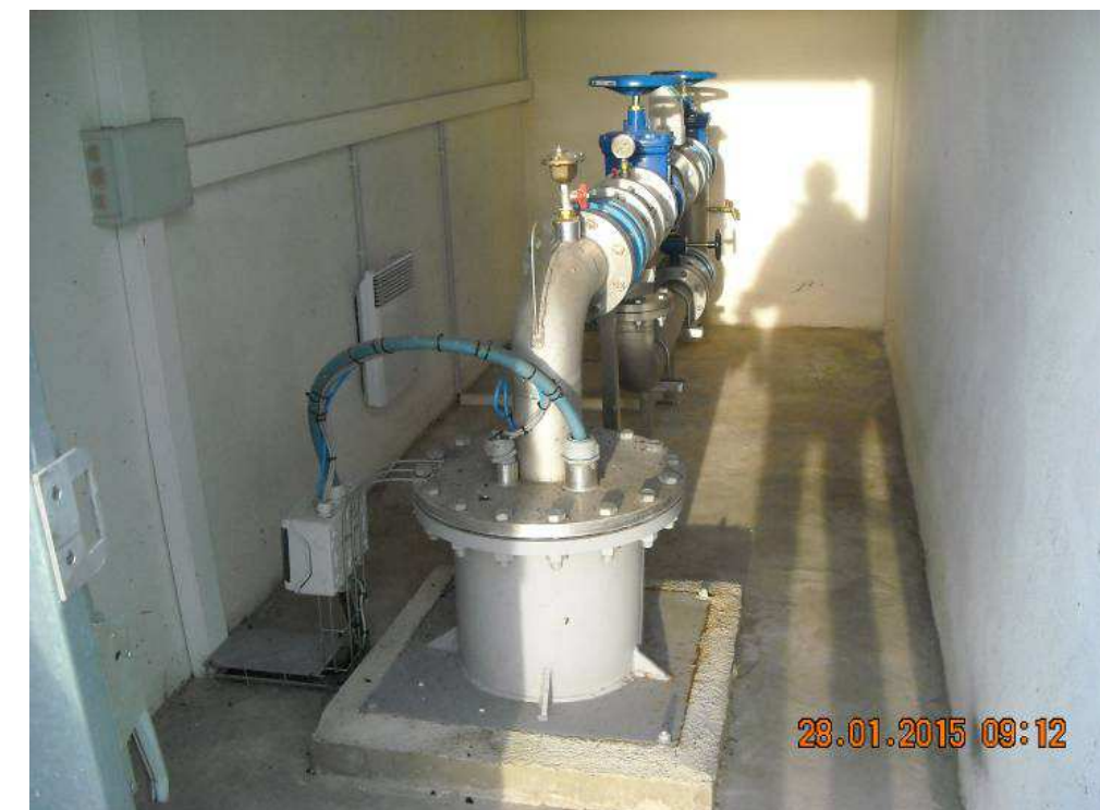
Photo 3 - Tête du forage Fe1
