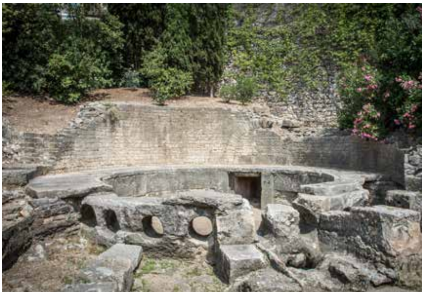
LE CASTELLUM DIVISORIUM PERMETTAIT L'ASSAINISSEMENT DES EAUX DE LA VILLE DE NÎMES DÈS LE I er SIÈCLE AP J.-C.
