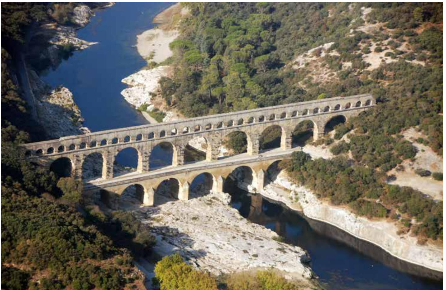
PLUS DE 50 000 TONNES DE PIERRES FURENT NÉCESSAIRES POUR CONSTRUIRE CE PONT AQUEDUC ROMAIN
