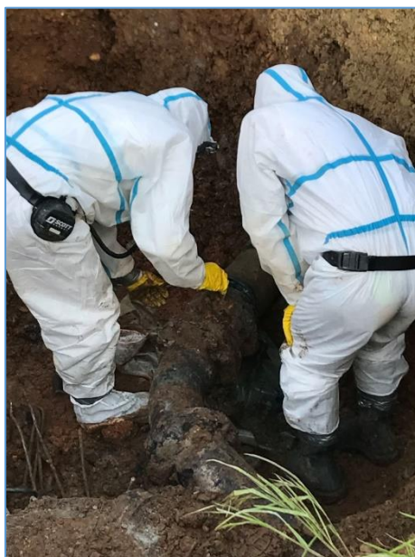
Figure 5. Opération de dépose de réseau en amiante.
