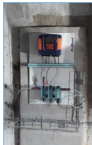
- Mise en place d'un analyseur de chlore au réservoir de Redessan
