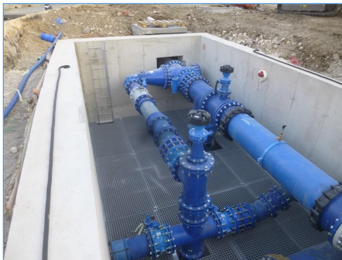
Figure 6. Restructuration de l'interconnexion entre les adducteurs AEP DN 1000 et DN 800 à Nîmes
