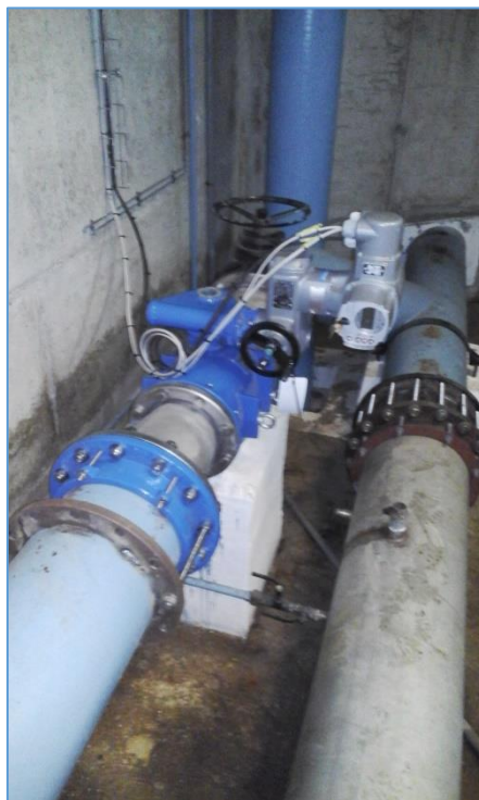
Figure 3. Mise en place d'une vanne de régulation au réservoir Terres de Rouvières, Nîmes.
