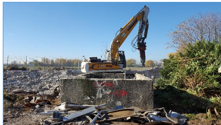
Figure 10: Démolition de la station de traitement de Caissargues
