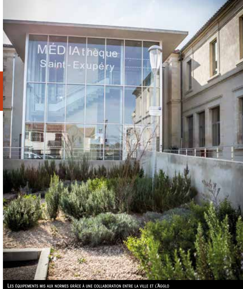
LES ÉQUIPEMENTS MIS AUX NORMES GRÂCE À UNE COLLABORATION ENTRE LA VILLE ET L'AGGLO
