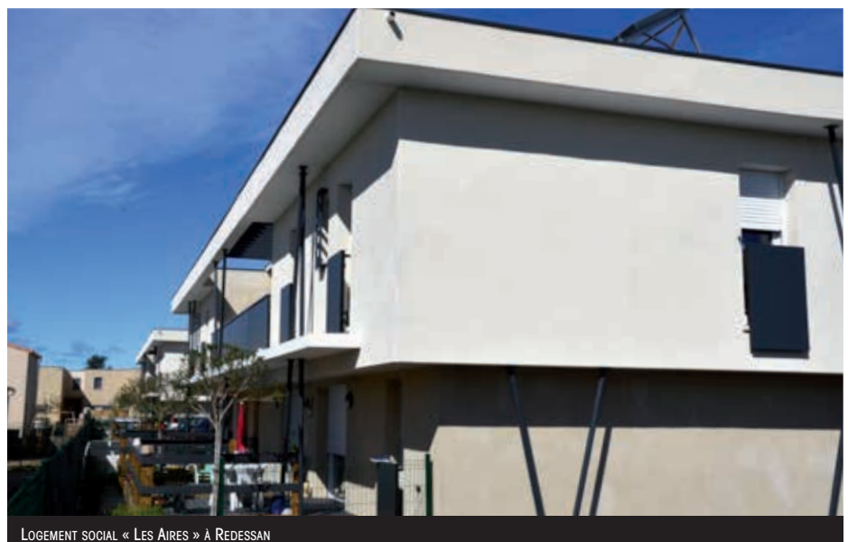
LOGEMENT SOCIAL « LES AIRES » À REDESSAN
