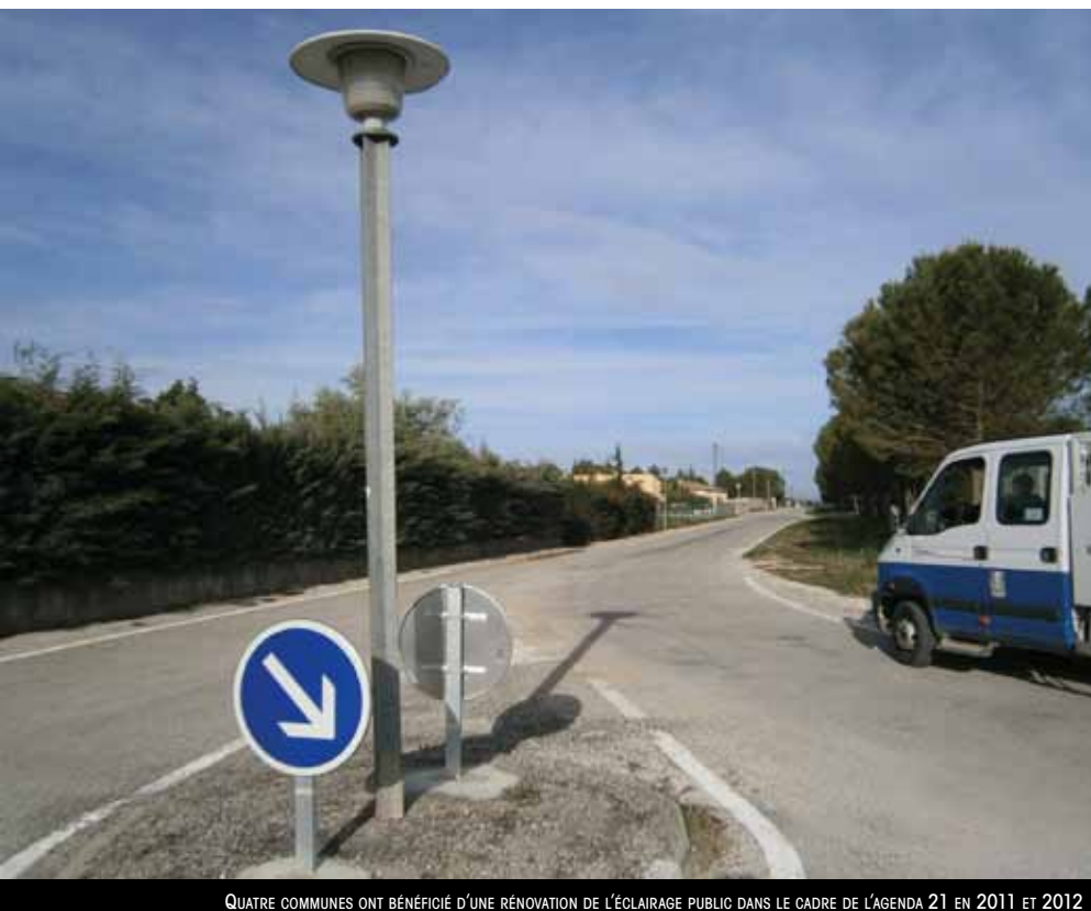
QUATRE COMMUNES ONT BÉNÉFICIÉ D'UNE RÉNOVATION DE L'ÉCLAIRAGE PUBLIC DANS LE CADRE DE L'AGENDA 21 EN 2011 ET 2012
