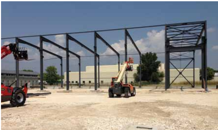
LES NOUVEAUX LOCAUX DE SUD MÉTAL SONT EN CONSTRUCTION SUR L'ACTIPARC GRÉZAN
