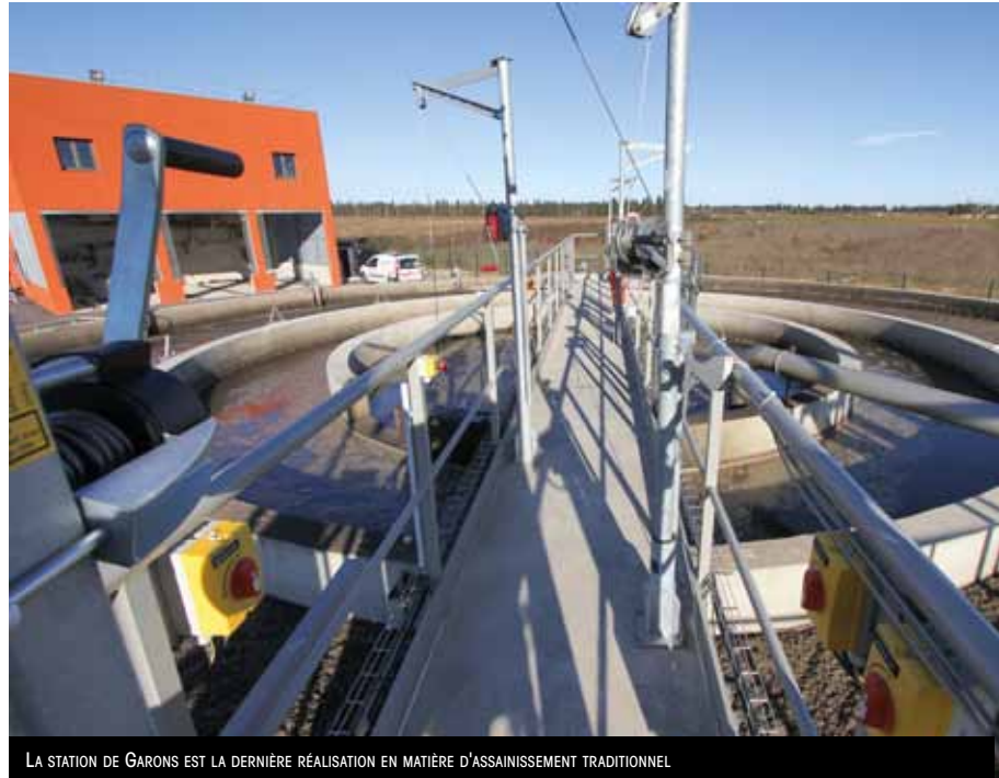
LA STATION DE GARONS EST LA DERNIÈRE RÉALISATION EN MATIÈRE D'ASSAINISSEMENT TRADITIONNEL
