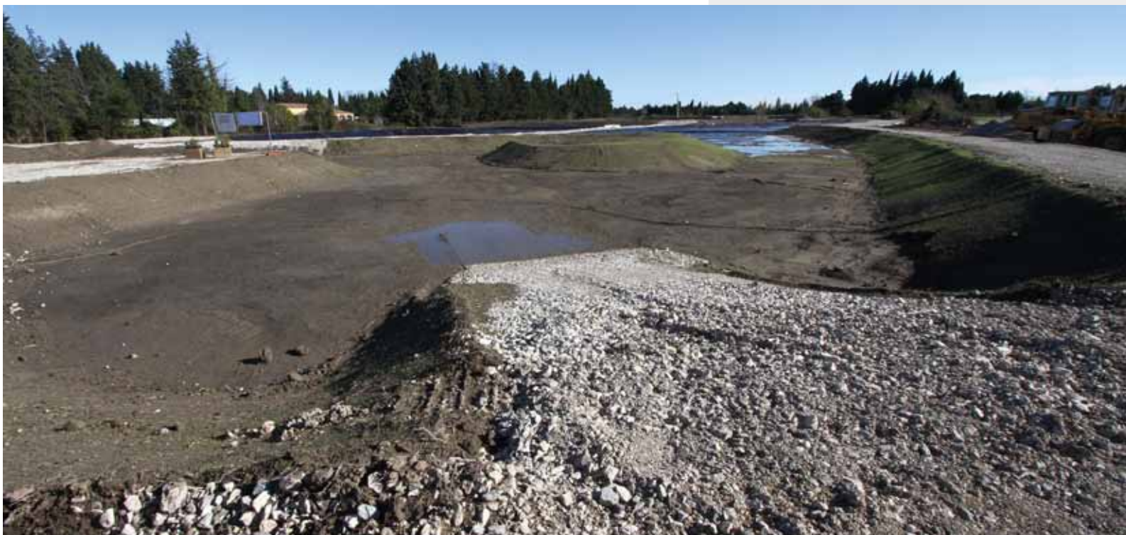
LES TRAVAUX DE TERRASSEMENT DE LA ZONE VÉGÉTALISÉE SONT TERMINÉS
