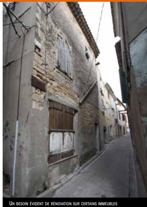
UN BESOIN ÉVIDENT DE RÉNOVATION SUR CERTAINS IMMEUBLES
