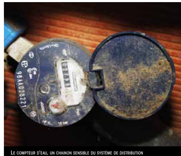
LE COMPTEUR D'EAU, UN CHAÎNON SENSIBLE DU SYSTÈME DE DISTRIBUTION
