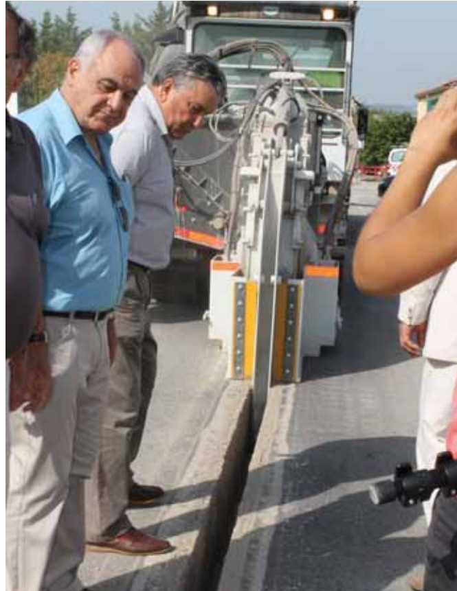
RÉALISATION D'UNE MICRO TRANCHEE POUR LA POSE DE FIBRE OPTIQUE À LA CALMETTE EN PRÉSENCE DU PRÉSIDENT ET DES ÉLUS COMMUNAUTAIRES
