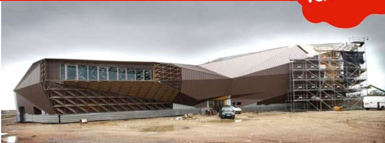
LA MISE EN PLACE DE L'ENVELOPPE EXTÉRIEURE DU BÂTIMENT EST PRESQUE ACHÉVÉE
