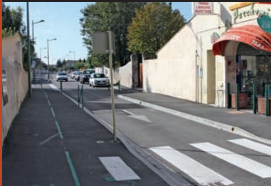
LA RUE DE SAINT-GILLES, RÉCEMMENT RÉNOVÉE
