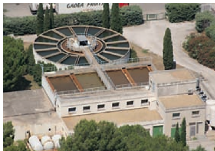
LA STATION DE POTABILISATION DE SAINT-CÉSAIRE
