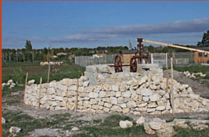
LE Puits à roue en cours de rénovation
