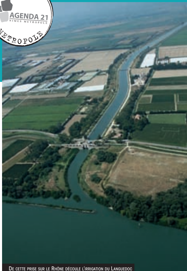
DE CETTE PRISE SUR LE RHÔNE DÉCOULE L'IRRIGATION DU LANGUEDOC
