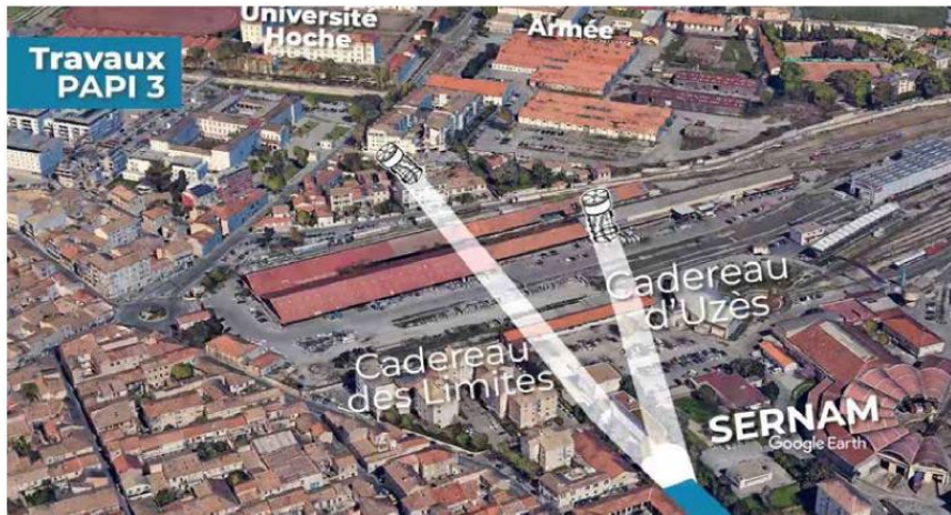
Le tunnelier à venir sous la ville de Nîmes.
