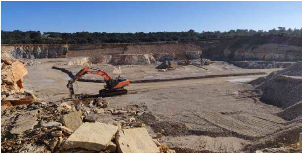
Chantier du bassin-carrière des Antiquailles.
