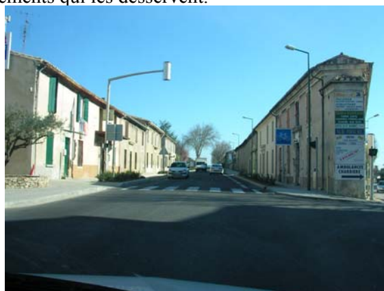
Bezouze : largeur trop faible de l'aménagement et forte insécurité du fait des véhicules très proches et de la bordure de trottoir
