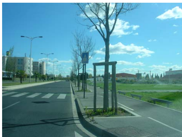
Avenue du Languedoc : la piste prend la totalité du trottoir : les piétons n'ont plus d'espace
