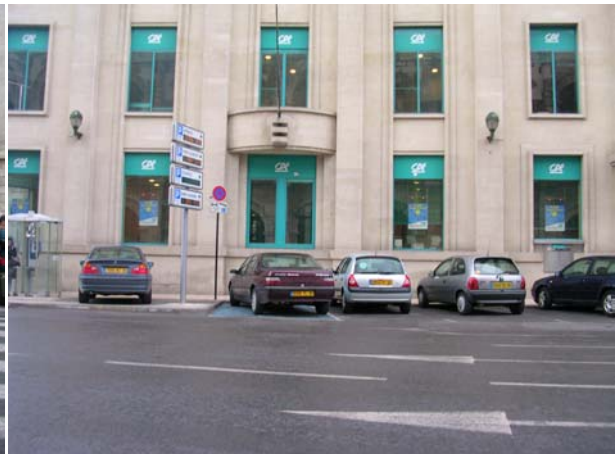
Place non aménagée : largeur insuffisante, trottoir non rabaissé
