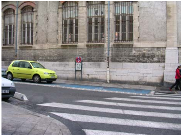
Place correctement aménagée : mise à niveau du trottoir ce qui laisse une largeur suffisante et évite les pentes et ressauts. La signalisation est toutefois à mettre aux normes
