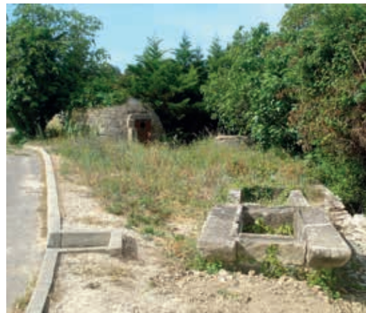
Les vestiges du Puits Vieux, impasse du Vieux Moulin, avec au fond, le dôme en pierres qui abrite encore le mécanisme de la pompe
