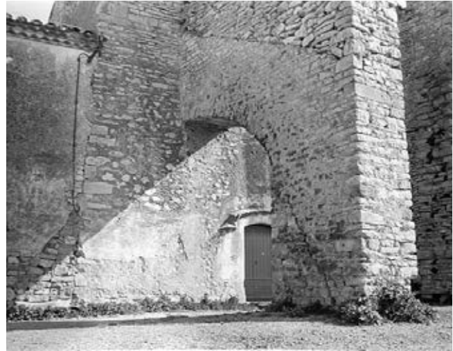
Les deux assises de pierres de l'arc-boutant, bien perceptibles sur cette photo de 1961, prise du côté occidental
