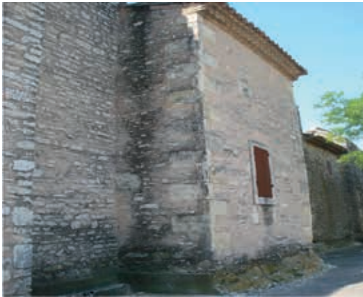
Sur la façade nord, le prolongement se traduit par un décrochement, qui correspond à la sacristie actuelle.
