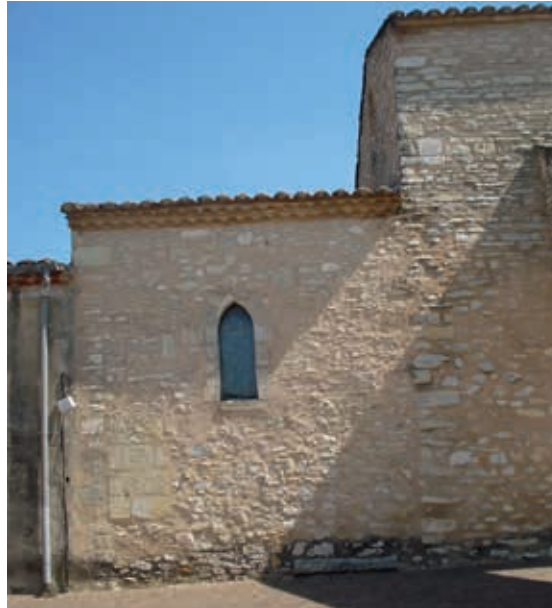
La partie la plus récente, à l'ouest, vue depuis le sud.
